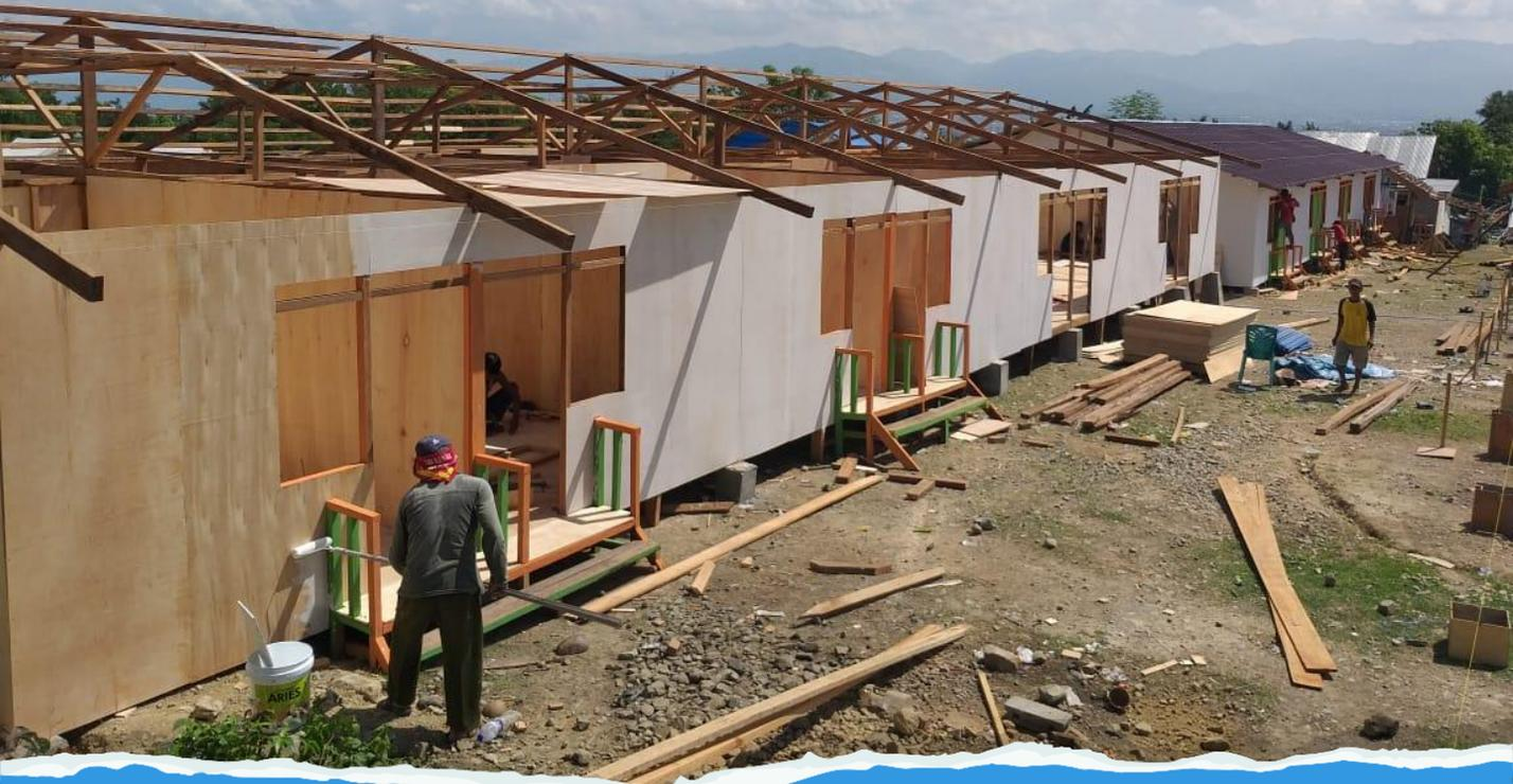
Proses pemasangan tangga shelter dan rangka atap. Beberapa pekerja juga tampak tengah melakukan pengecatan pada beberapa sisi kayu dan plywood agar shelter terlihat lebih indah dan tahan lama.
