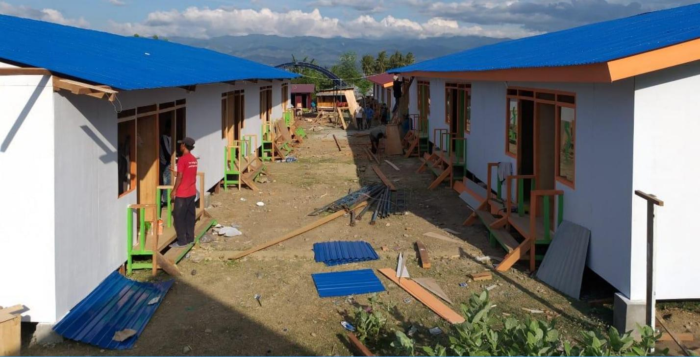
Pemasangan pintu dan kaca jendela. Pembangunan ICS memasuki tahap 80% progress pembangunan. Sebanyak 6 lokal shelter masing-masing dibangun dengan 16 pintu dan berukuran 9,5 meter x 24 meter. Total terdapat 96 unit hunian yang siap dihuni oleh 96 keluarga
