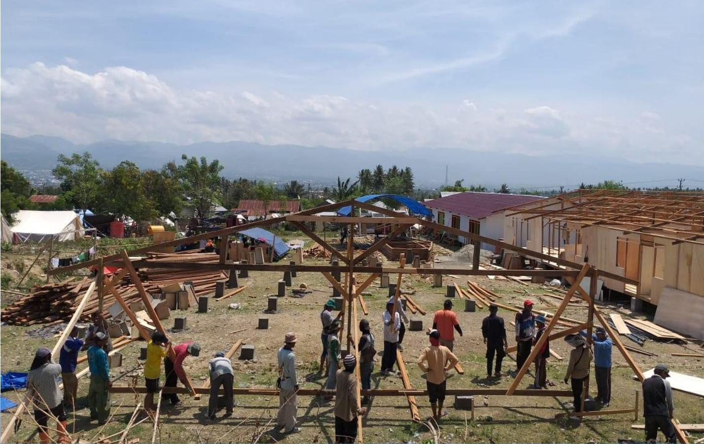
Pembuatan pondasi rumah menggunakan umpak beton yang diletakkan diatas tanah yang telah padat atau keras. Umpak digunakan karena bangunan rumah berbahan dasar kayu
